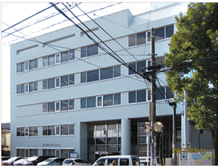
空調修理がなされる東南公共センター
