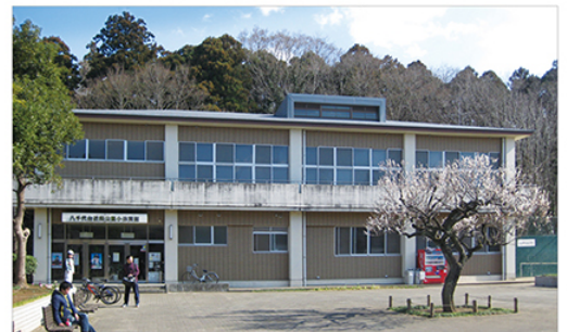
雨漏り改修がされる近隣公園小体育館
