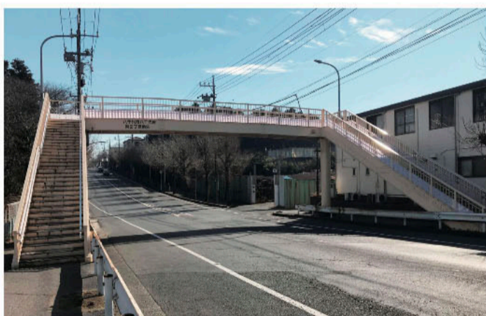
通学路なのに大変老朽化して危険であった八千代台東小前の歩道橋はキレイに改修されました。
