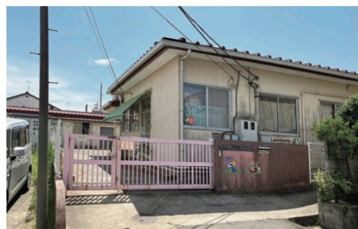
八千代台南保育園は1、2歳児に特化した保育園に。そのための改修と同時に懸案だった駐車場を来年度建設！
