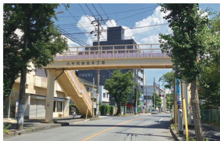
八千代台小前の歩道橋改修！ (八千代台北6丁目地先)
