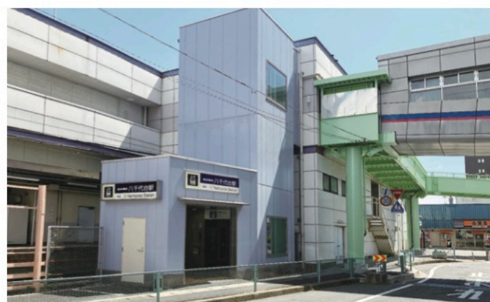
八千代台駅西口のエレベーターの設置！
