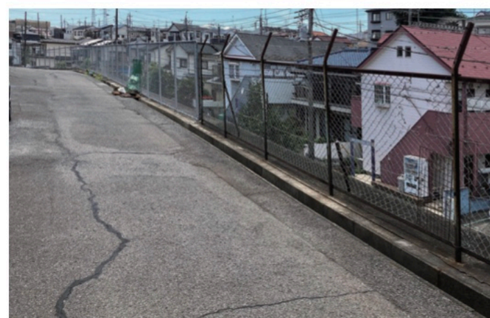
八千代台東5丁目急傾斜地崩壊危険区域の金網フェンスの古くなった箇所は本年度中に新しく改修！
