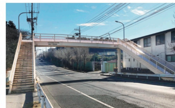
通学路なのに大変老朽化して危険であった八千代台東小前(八千代台東2丁目地先)の歩道橋はキレイに改修されました！
